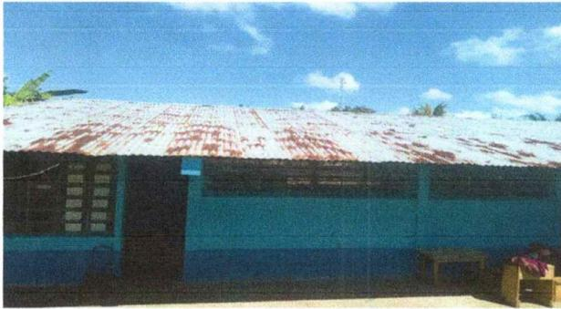
Foto 1: Láminas del techo de la escuela están deterioradas por esa razón hay que cambiar.
