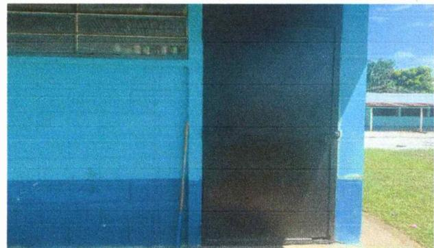
Foto 4: La puerta está en mal estado en la parte de abajo y por esa razón se va a comprar.
