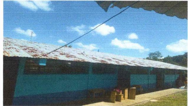
Foto 2: Láminas con oxidación por esa razón se realizará la compra de láminas troqueladas.
